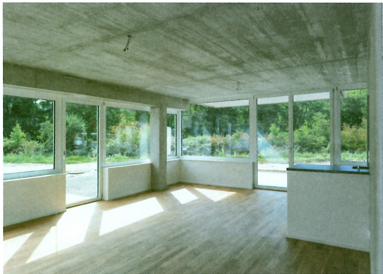
Stütze, Balken und Decke aus Beton bilden ein Tragsystem. Es lässt den freien Einbau der Räume zu.
